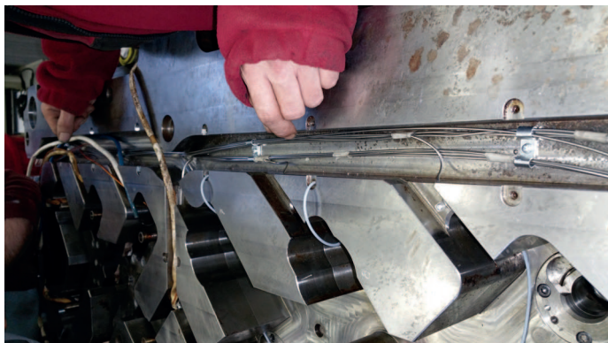
Obrázek 21 - instalace senzorových trubiček do stávající drážky kabeláže horkého systému
