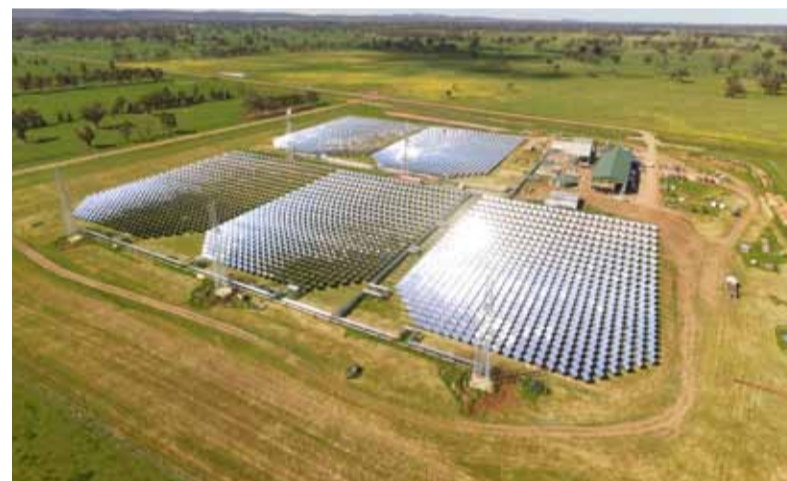
Demonstrační elektrárna Jemalong, NSW CSP 6 MW epelných - 5 polí s naklápěcími věžemi a propojovacími potrubními rozvody. Vlastní energetický blok v pozadí
