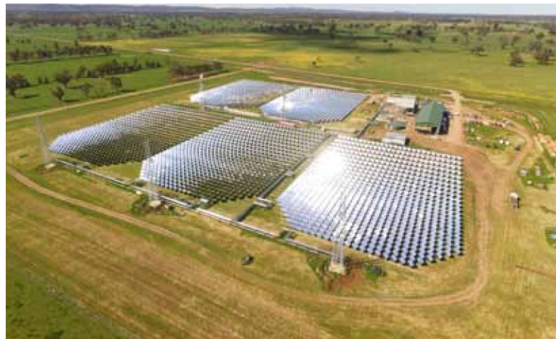
Demonstrační elektrárna Jemalong, NSW CSP 6 MW tepelných – 5 polí s naklápěcími věžemi a propojovacími potrubními rozvody. Vlastní energetický blok v pozadí
