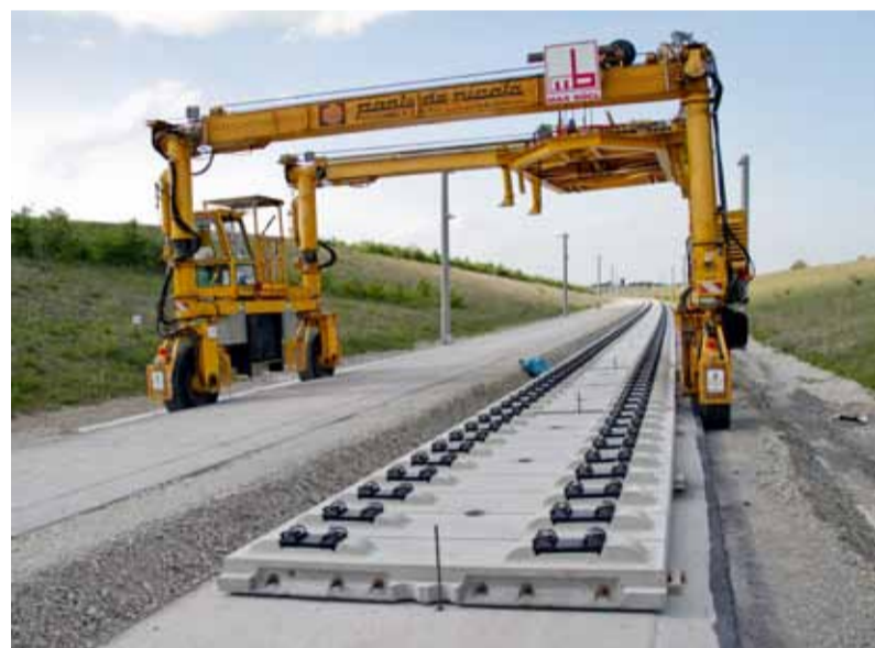
Montáž podkladních desek pevné dráhy systém Bögl poblíž Erfurtu
