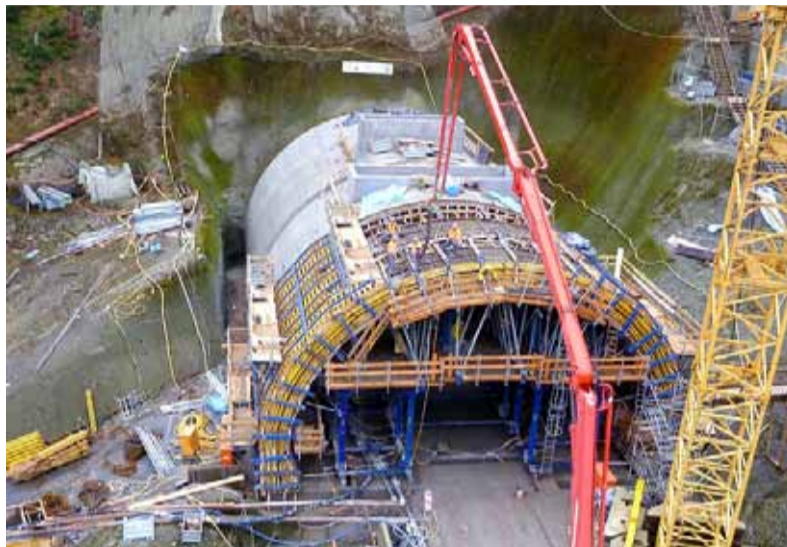
Betonáž severního portálu tunelu Blessberg, 2013
