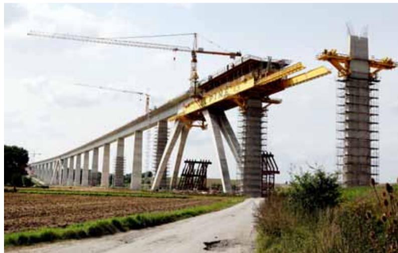
Proudová metoda stavby Unstruttalbrücke (2660m) posuvným bedněním
