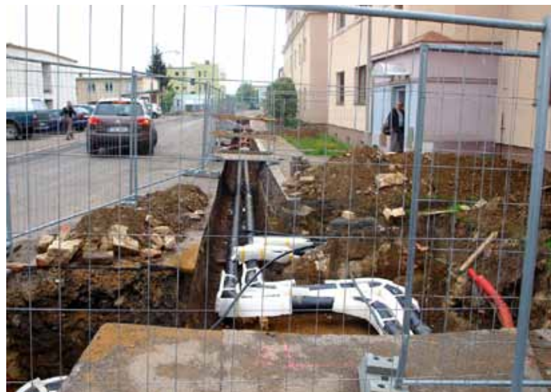
Pohled na položené potrubí před jedním z obytných domů patřících městu
