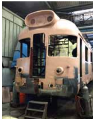
Hrubé mech. práce - fotografie z opravy vozidla v dílně CZ LOKO v České Třebové
