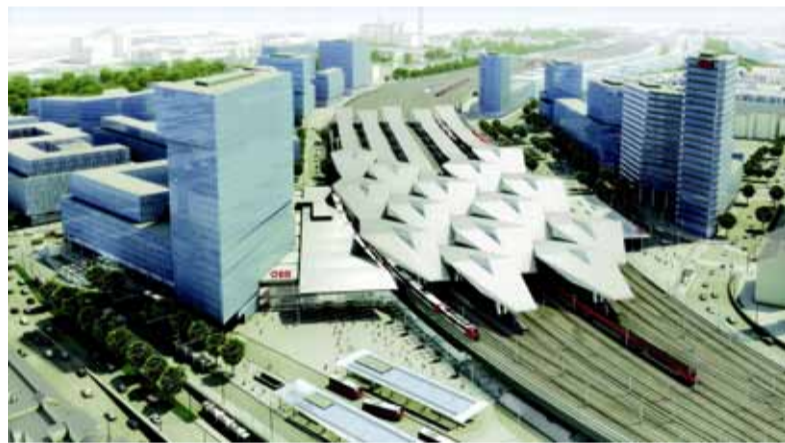
Wiener Hauptbahnhof s „diamantovou střešou“ s přiléhající výškovou budovou BahnhofCity a protilehlým mrakodrapem ředitelství ÖBB (Foto ÖBB)
