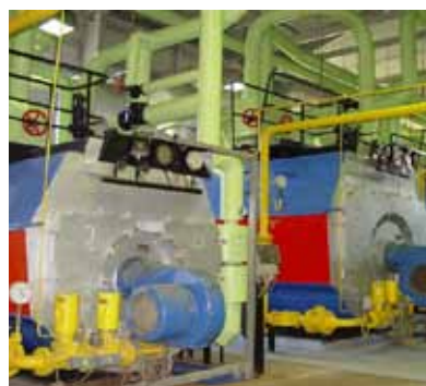
Původní teplovodní kotle ČKD Dukla, rok výroby 1976
