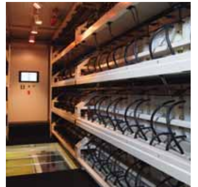
↗ Zařízení na ukládání elektrické energie ze solárního a větrného zdroje s názvem CellCube, které vyvinula společnost Cellstrom – součást koncernu DMG MORI SEIKI
