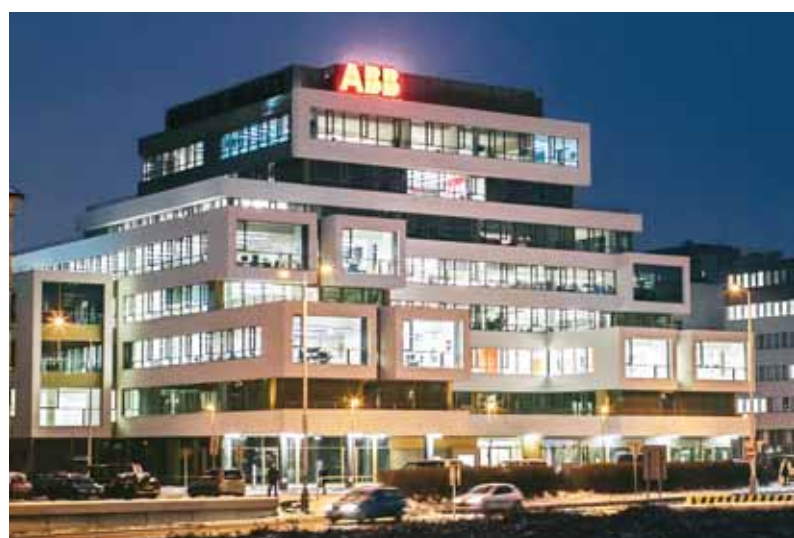
Obr. 1: Rekonstruovaná budova Qubix využívá HVAC systémy
