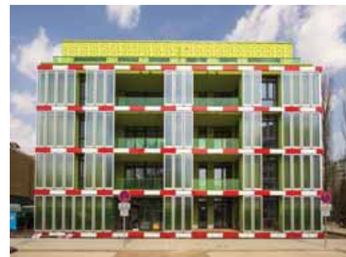
Skleněná fasáda s řasami vyrábí teplo a biomasu
