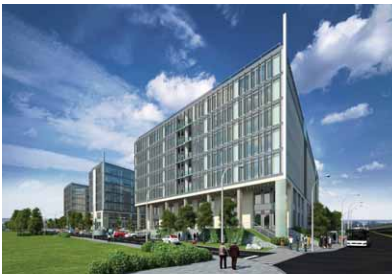
Floreasca Park v Bukurešti využívá geotermálních tepelných čerpadel
