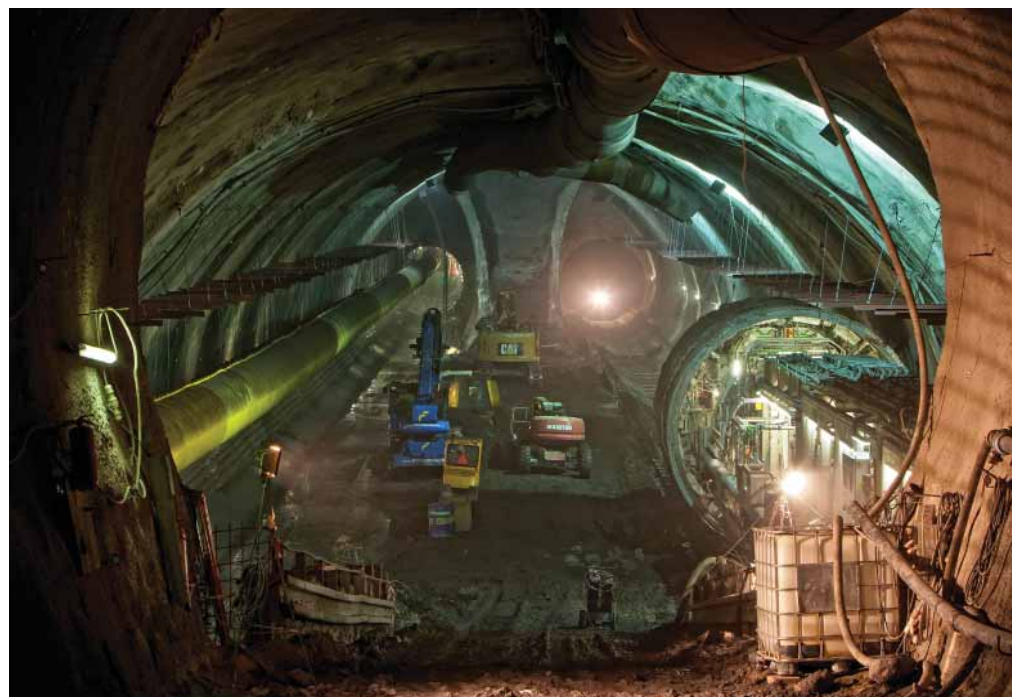
Pohled do stanice Červený Vrch během protahování stroje TBM
